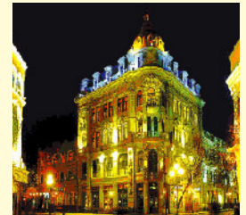
ハルビン市内にはいくつもの欧風建築が残っている
